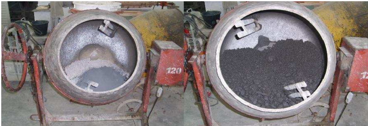
(a) agregados secos na betoneira
