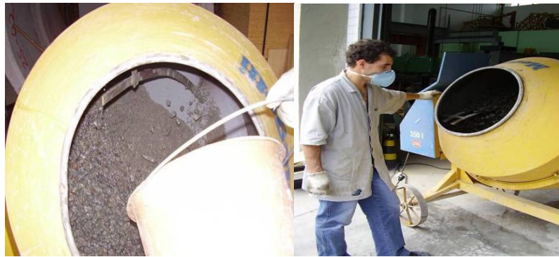
Figura 4.14 – Colocação da água e período de mistura para produção do CCR
