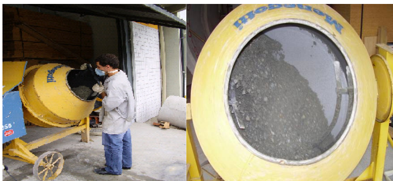
Figura 4.13 – Colocação e mistura dos materiais na betoneira de 320 litros
