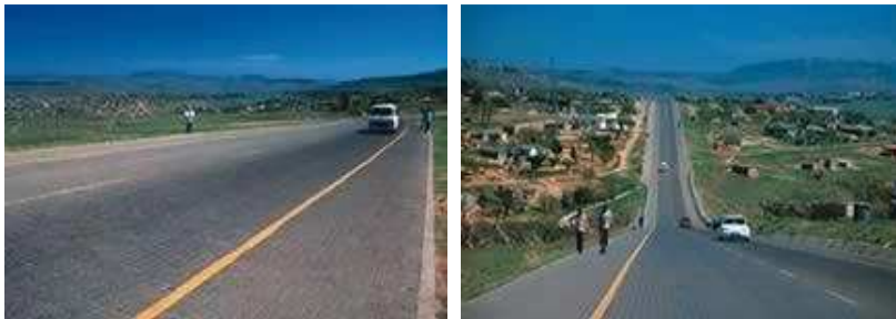
Figura 2.12 – Rodovia em Qwa-Qwa, África do Sul (MADRID, 2004 apud MULLER, 2005).
